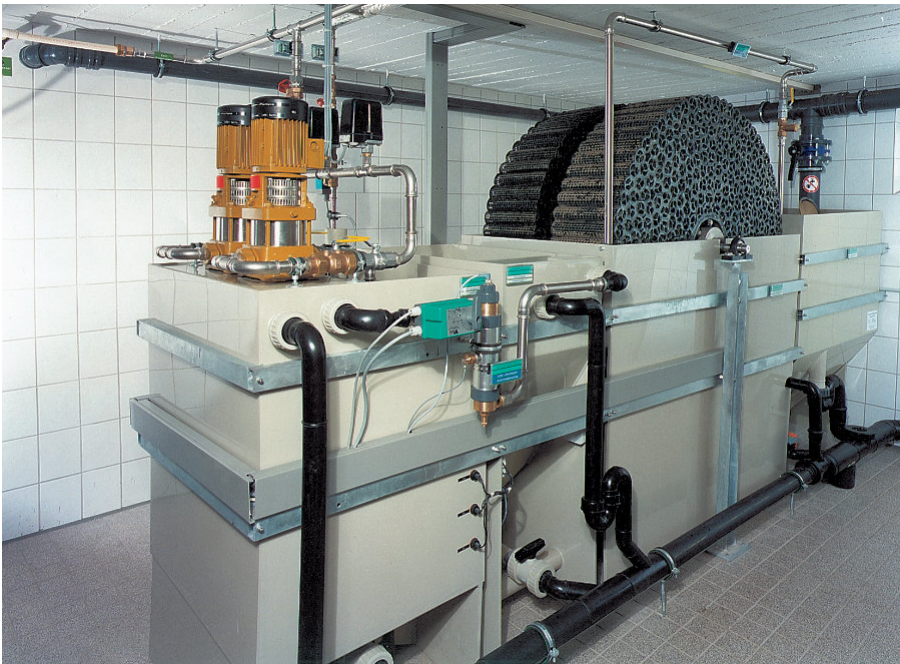
Abb. 84: Rotations-Tauchtropfkörper, Grauwasseranlage Hannover-Hä- gewiesen (Foto: Knut Zeisel)
