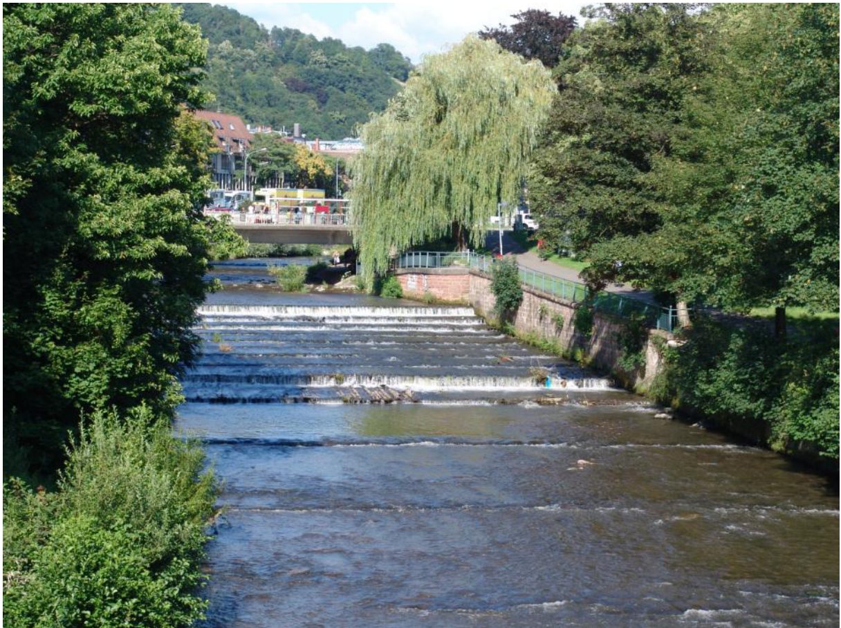
Das Schwabentorwehr im Jahr 2013 von flussabwärts gesehen. Die 1871 errichtete Holzrampe hat eine Breite von 24 Metern und eine Länge von fast 50 Metern. Vor allem die untere Baumstammkaskade war schon im Jahr 2013 im Verfall begriffen (Foto: Nikolaus Geiler).
